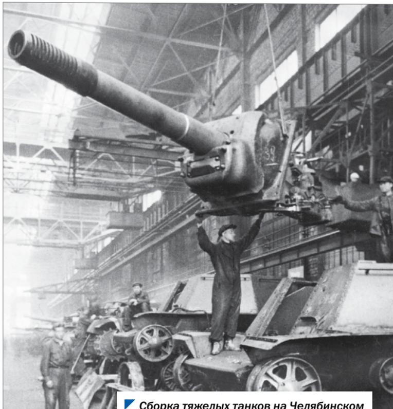
Сборка тяжелых танков на Челябинском Кировском заводе. 1945 г.
