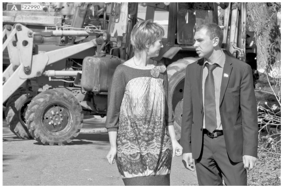
Депутат Михаил Видгоф и директор школы № 107 Наталья Широchenkova осматривают ход строительных работ возле учебного заведения.
