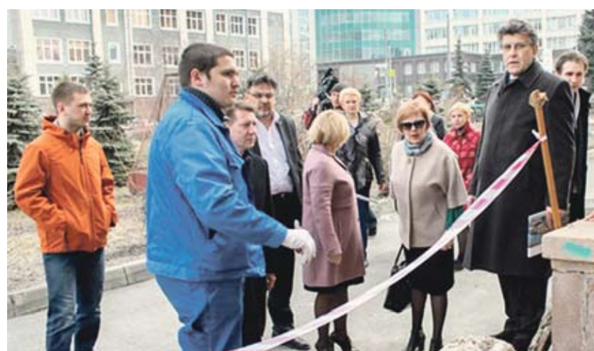
Александр Журавлев познакомился с ходом ремонтных работ и обратил внимание на необходимость их ускорения.
