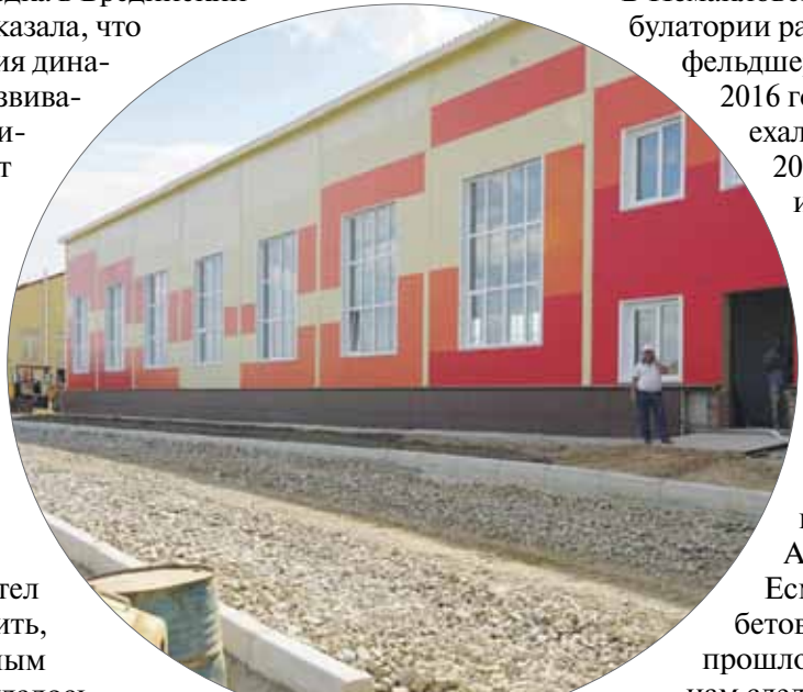
Современный ФОК сегодня строится в Брединском районе.
