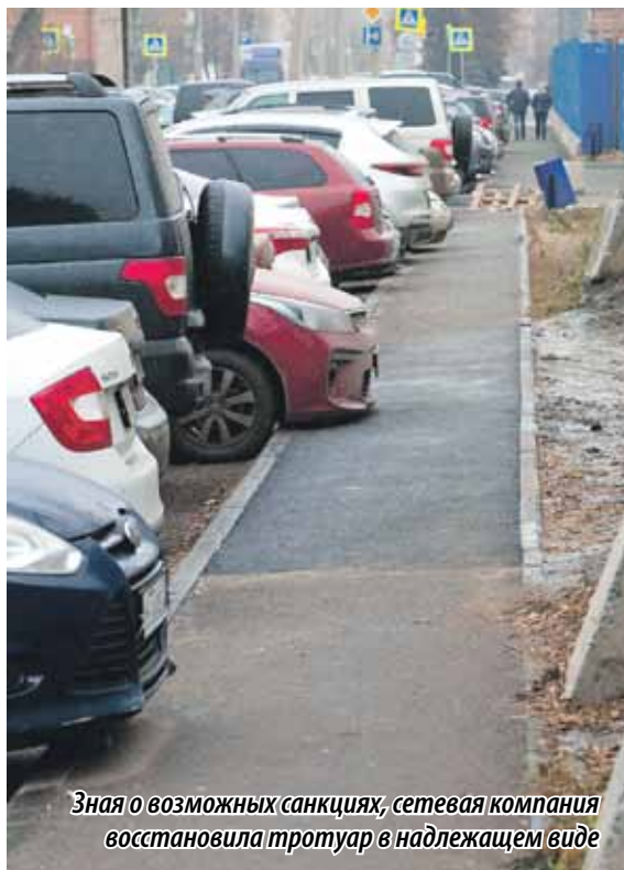
В Центральном районе Челябинска еженедельно контролируют порядка 50 объектов земляных работ
