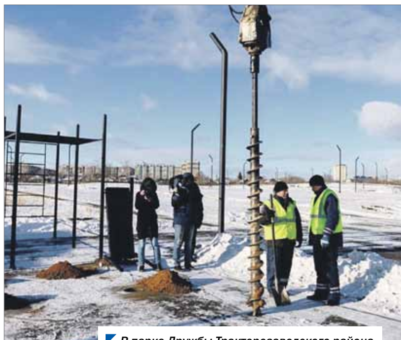
В парке Дружбы Тракторозаводского района завершается строительство воркаут-площадки.
