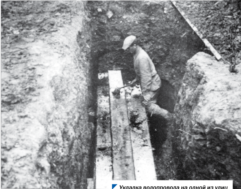
Укладка водопровода на одной из улиц Челябинска, 1930-е годы.
