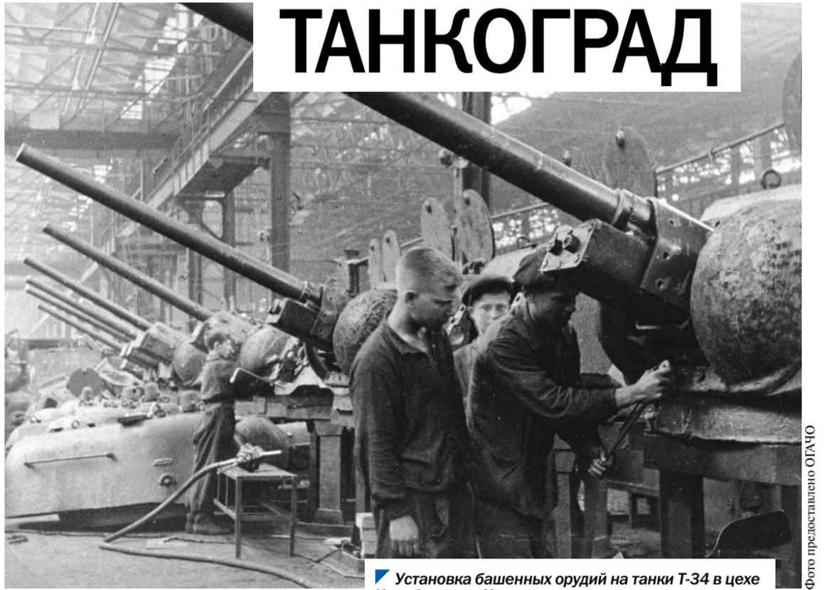
Установка башенных орудий на танки Т-34 в цехе Челябинского Кировского завода.
