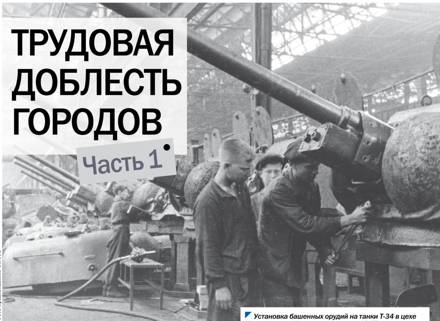
Установка башенных орудий на танки Т-34 в цехе Челябинского Кировского завода. 1945 год.
